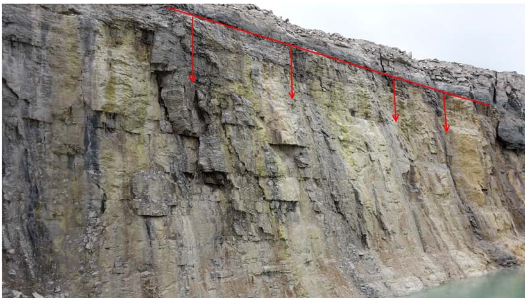
Figur 31. Läckage av vatten från pallvägg i norra delen av Centrala Klinthagen, som angränsar till högre beläget brytområde. Läge för utflöde och dropp är markerat med röd linje.
