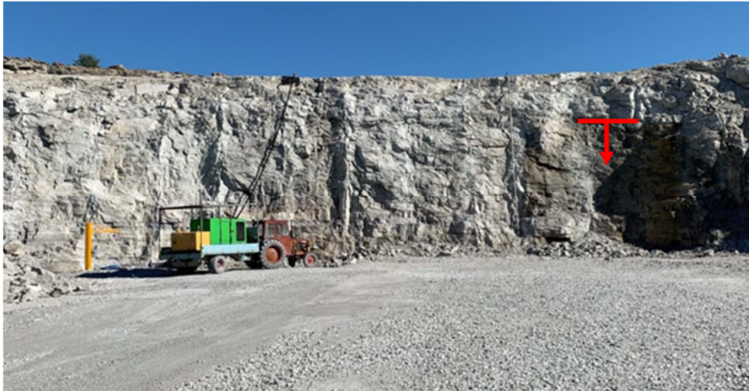
Figur 32. Synligt inläckage i södra delen av Centrala Klinthagen.
