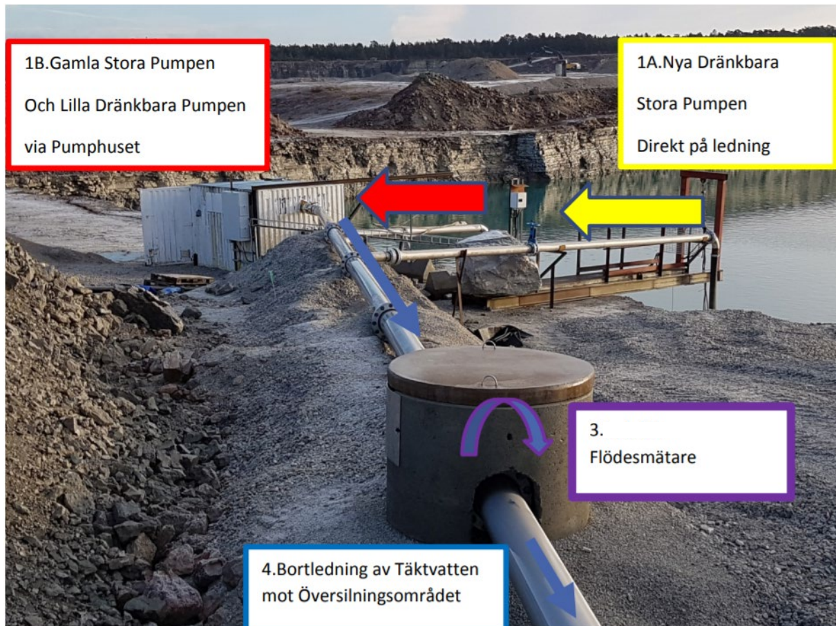
Figur 21. Pumpstation med vattenledning som avleder täktvatten i dagens vattenhantering. I betongkammaren sitter den induktiva flödesmätaren som mäter allt utgående vatten på ledningen. På ledningen med gul pil leds vatten från den nya stora dränkbara pumpen som kopplar på, på den stora ledningen mäts över flödesmätaren. På ledningen med röd pil leds vatten in i pumphuset för den stora gamla pumpen eller den lilla pumpen. Från pumphuset går vattnet ut på stora ledningen och mäts över flödesmätaren och vidare upp över pallkanten och ut till ett dike som för täktvattnet till översilningsområdet. Foton: Nordkalk.
