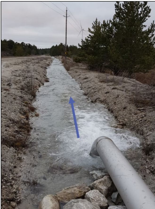
Figur 20. Klinthagentäktens utsläppspunkt. Täktvattnet som pumpas från Polenhålet leds genom en rörledning som mynnar ut i ett dike. Diket rinner till en översilningsyta. I bilden pumpas ungefär 140 l/s ut i diket. Foto: Nordkalk.
