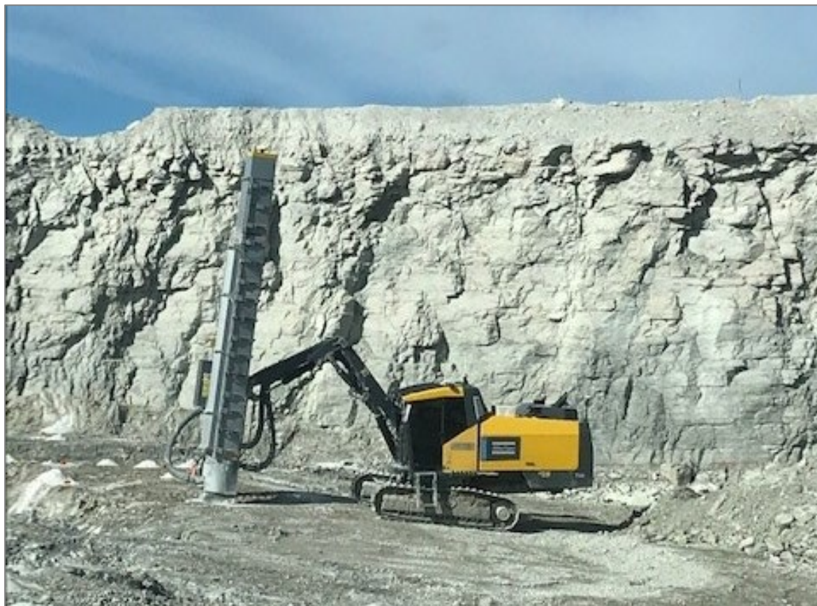
Figur 14. Borrrigg i Klinthagentäkten. Foto: NCC.
